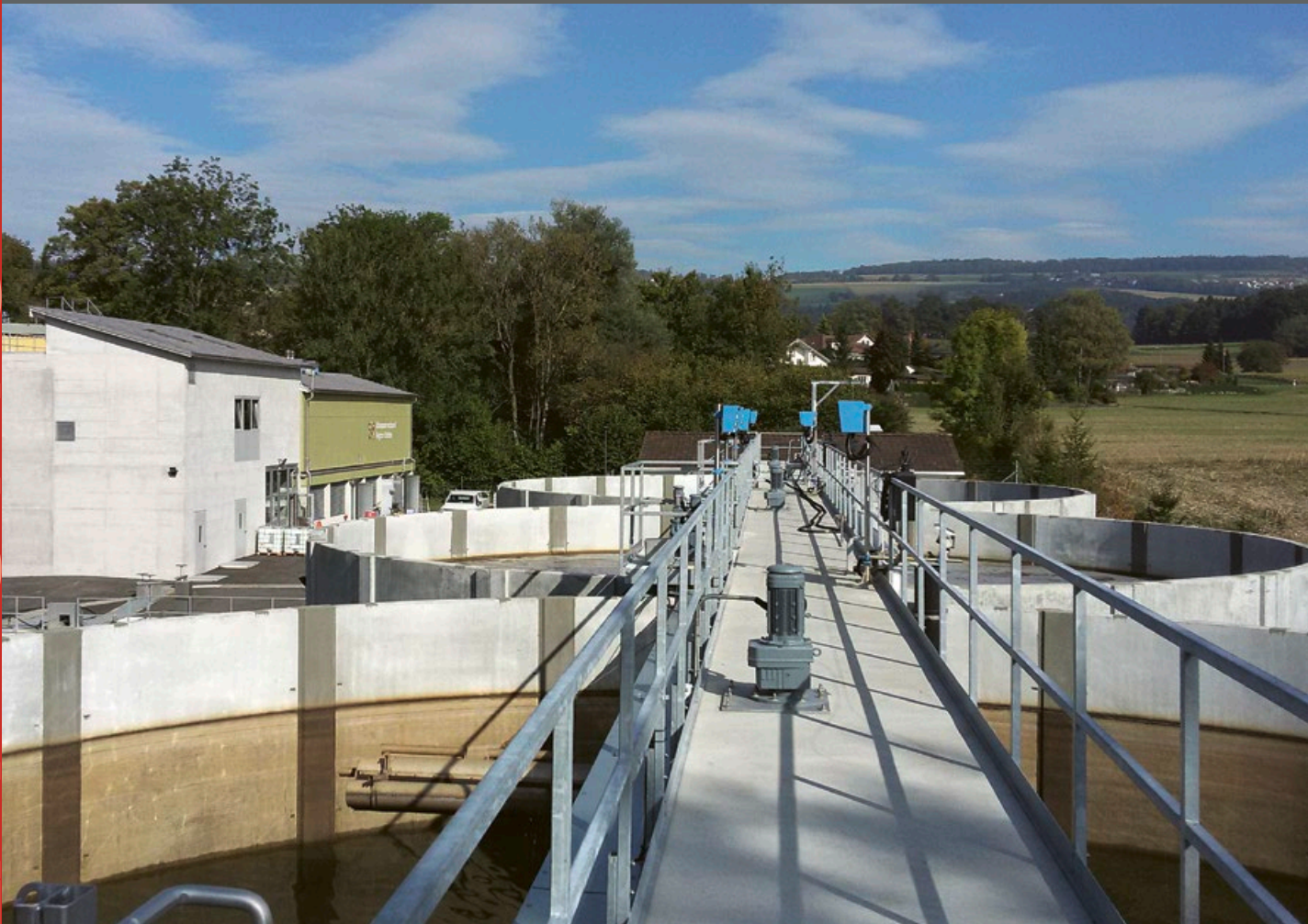
Neue Abwasserreinigungsanlage ARA Region Stetten
