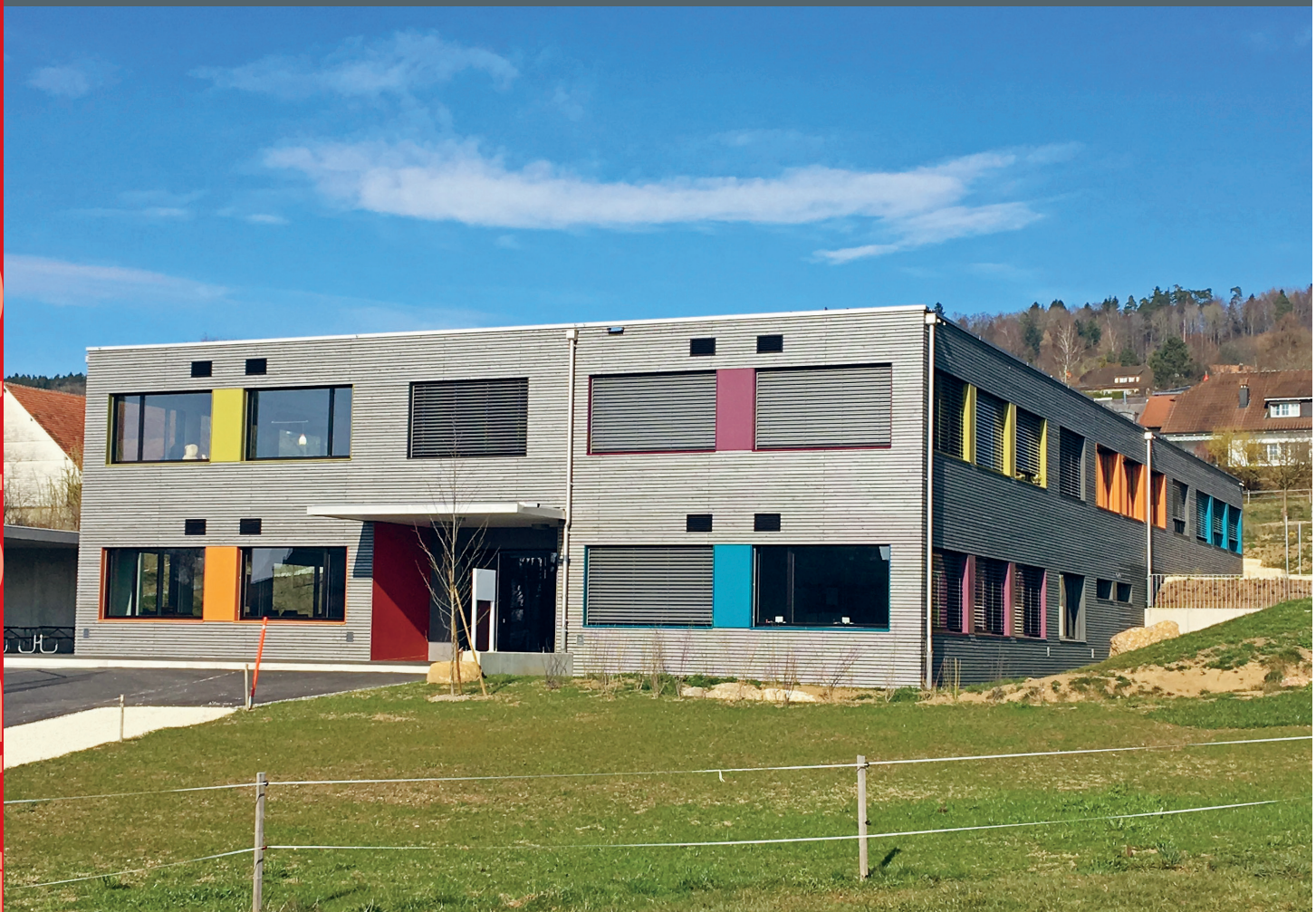
Neubau Schulhaus Bach
