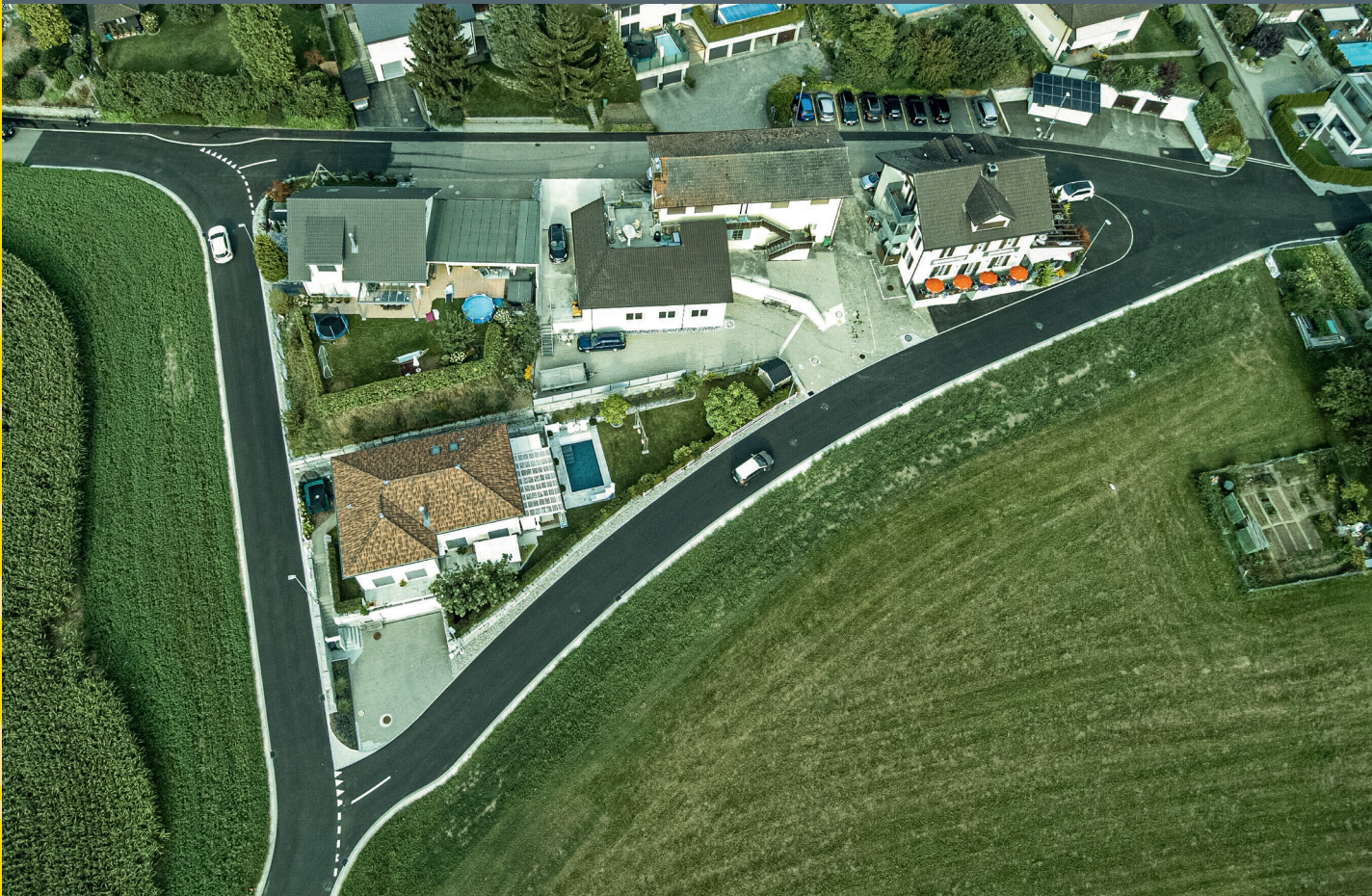
Neu saniertes Strassendreieck Högeler-/Dorfstrasse
