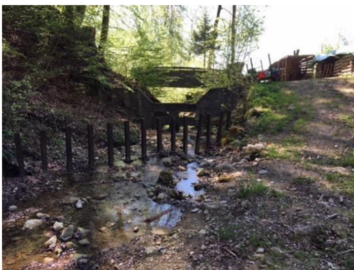
Abbildung 31 Talsperre am Tobelausgang mit Wartungszufahrt
