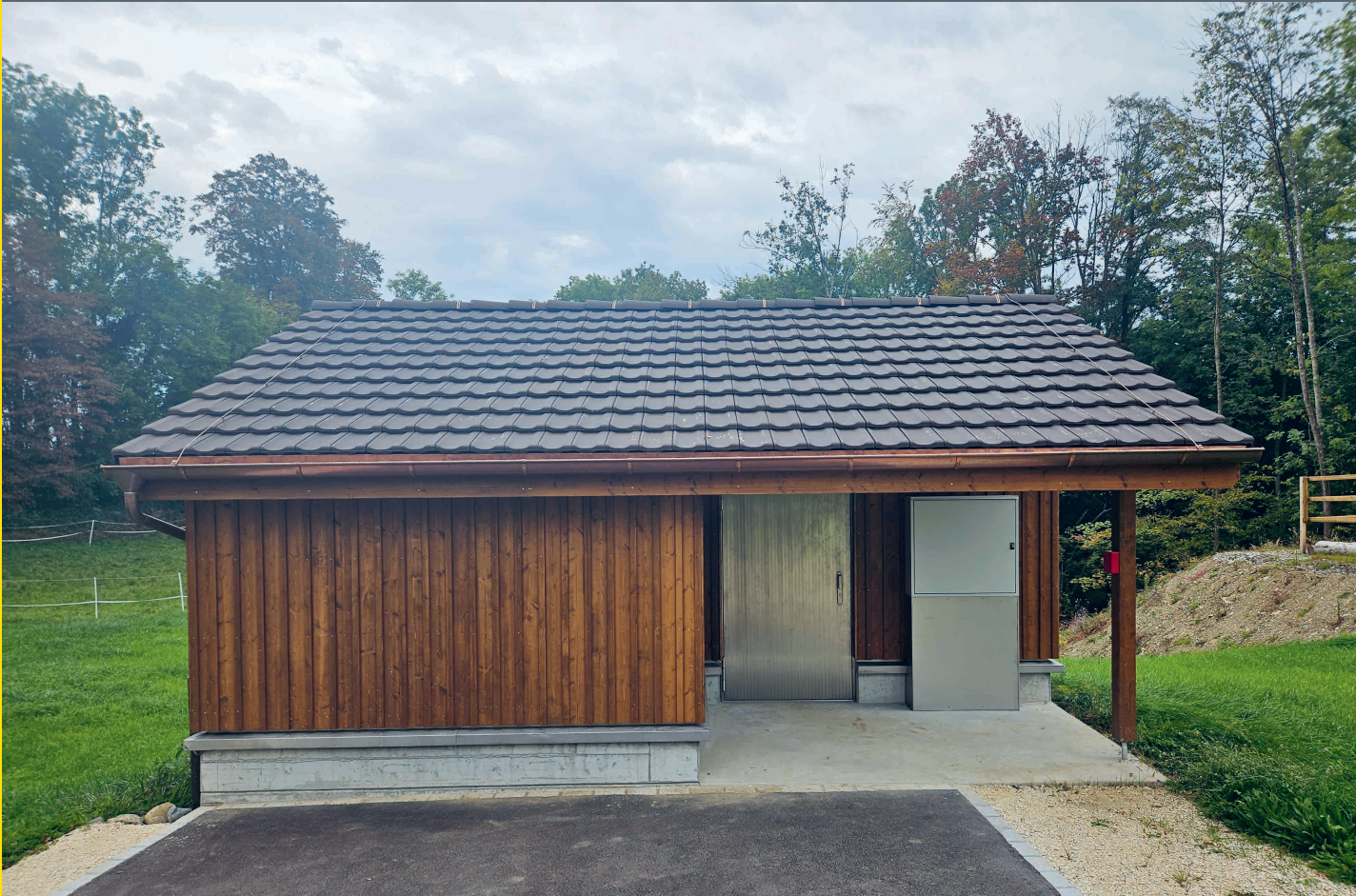
Betriebsgebäude neues Regenbecken
