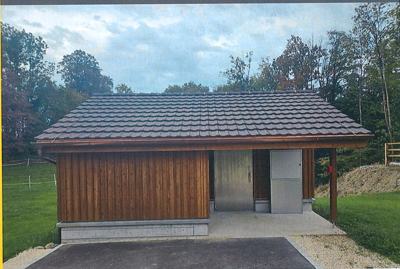
Betriebsgebäude neues Regenbecken
