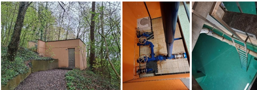
Abbildung 5 Reservoir Schürhau Aussenansicht, Betriebsraum und Kammern
