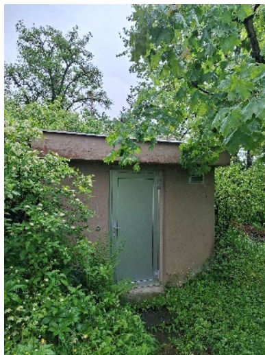
Bestehendes Pumpwerk Schürmatte
