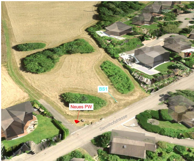
Geplanter Standort neues Pumpwerk Schürmatte
