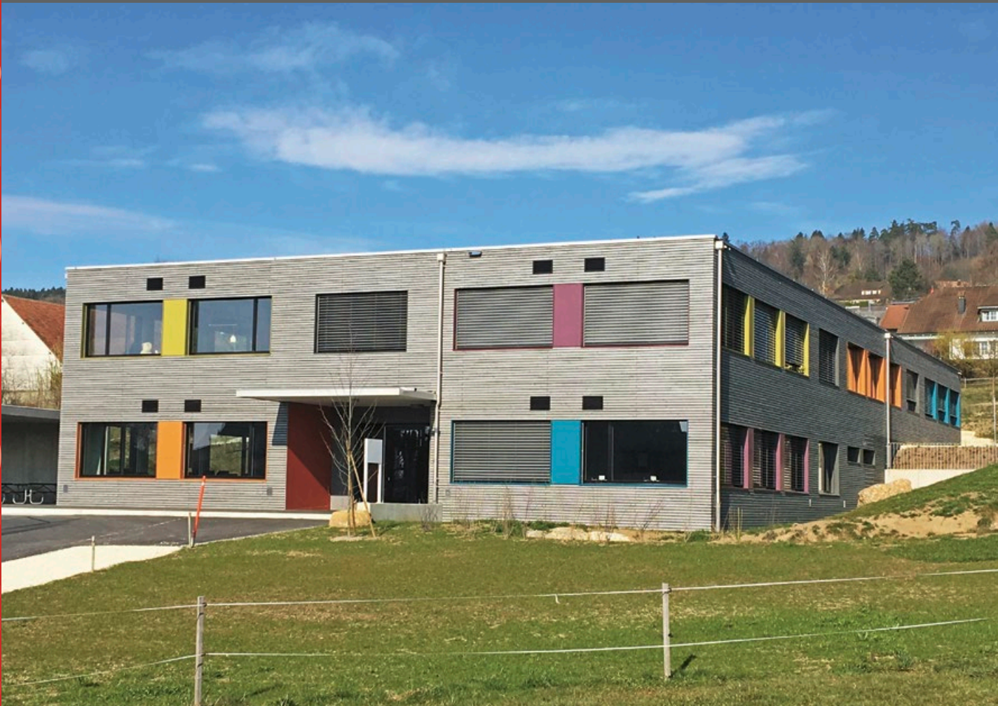
Neubau Schulhaus Bach
