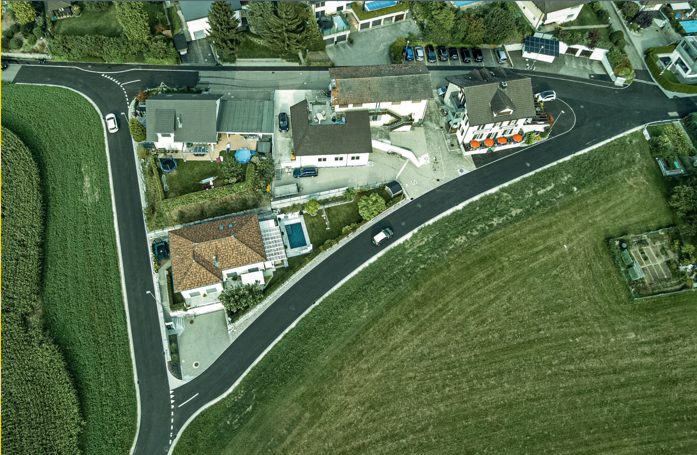
Neu saniertes Strassendreieck Högeler-/Dorfstrasse
